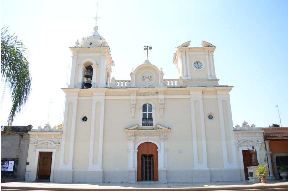
Fachada del Templo Sta. María de Guadalupe
